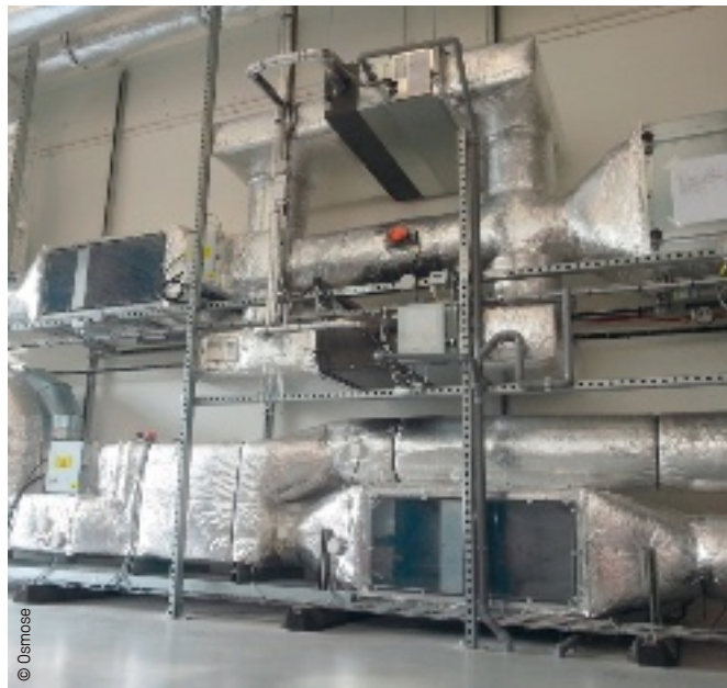
↑ Prototype de « Desiccant evaporative cooling » conçu par Osmose.
