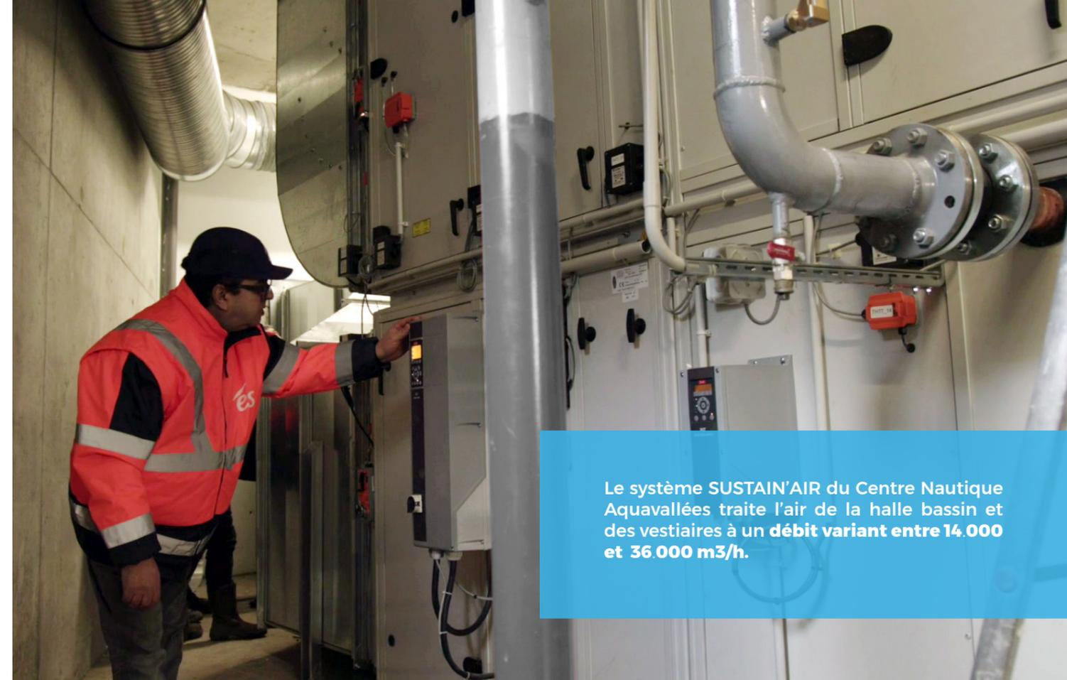
Le système SUSTAIN'AIR du Centre Nautique Aquavallées traite l'air de la halle bassin et des vestiaires à un débit variant entre 14.000 et 36.000 m<sup>3</sup>/h.
